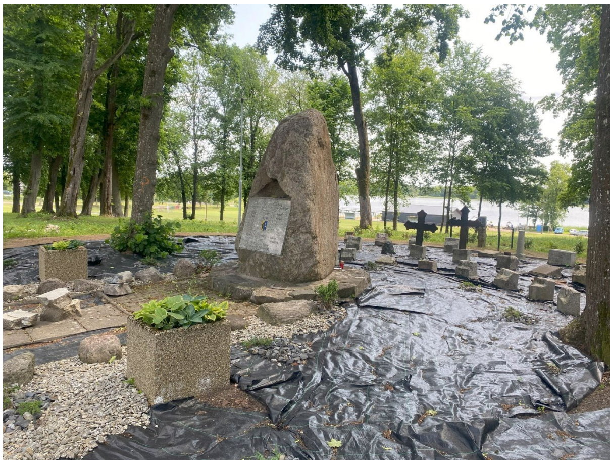
Zaawansowane roboty ziemne i porządkowe przy symbolicznym „Kamieniu pojednania”.
