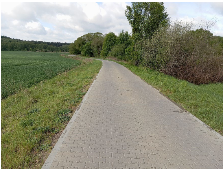
Droga wewnętrzna w obrębie Dolina po remoncie (droga do PSZOK)
