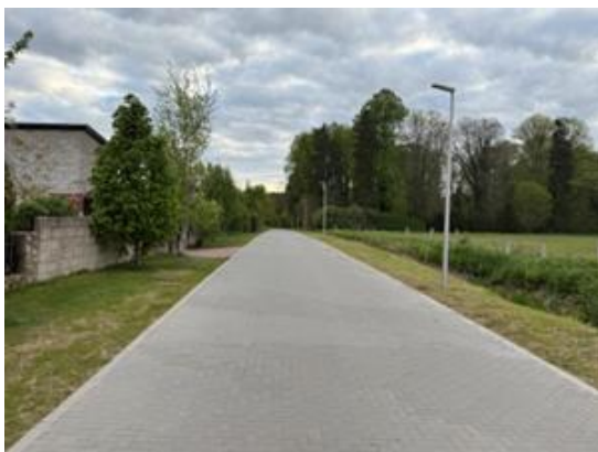
Przebudowa odcinka drogi w Zatomiu
