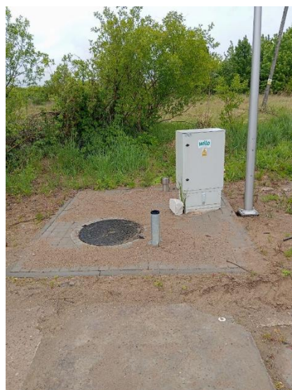
Budowa kanalizacji z Barnimia do Drawna
